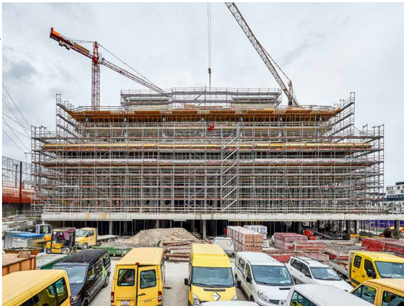
Sanierung und Umbau laufen auf Hochtouren: Die Arbeiten an der kompletten Erneuerung des 1991 errichteten Gebäudes werden am Ende fast vier Jahre dauern. Die Planung der komplexen Aufgabe begann indes schon 2007, als der Auftrag erteilt wurde.
