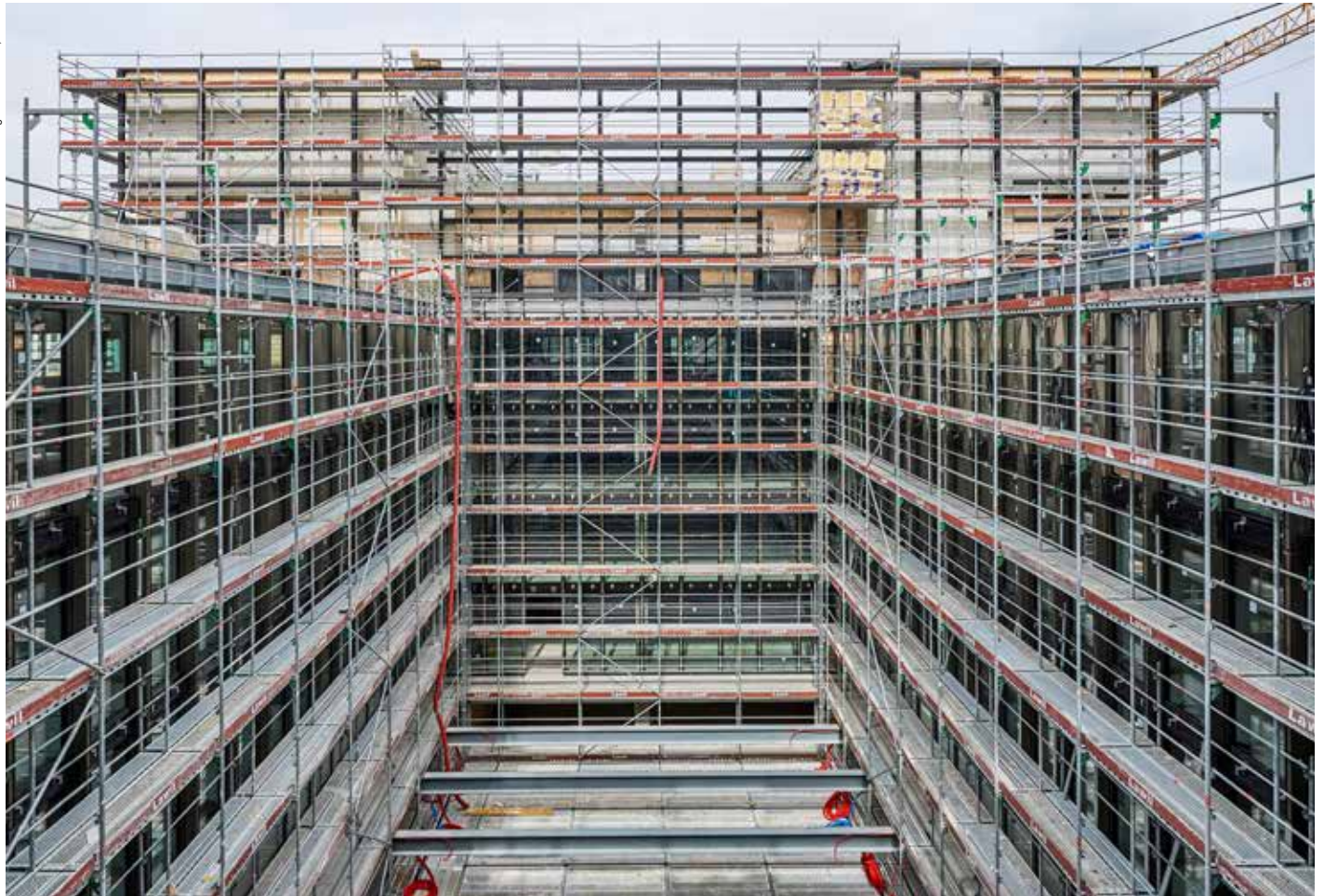
Eine wichtige Umbaumaassnahme waren die Schnitte durchs ganze Gebäude, die Licht ins Innere bringen. Die Atrien sind mit Glasdächern bedeckt.
