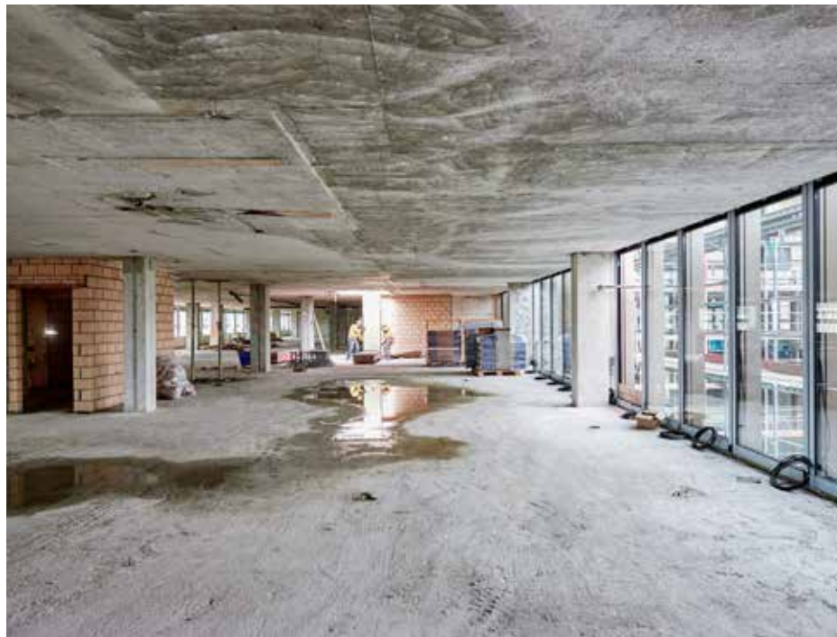
Die teilweise sehr tiefen Räume des Bürogebäudes werden jetzt durch den Umbau wesentlich besser mit Tageslicht versorgt.
