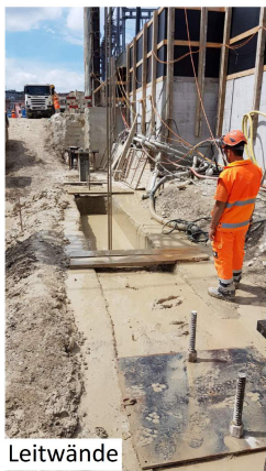
Schema Bauablauf Schlitzwandaufstellung
