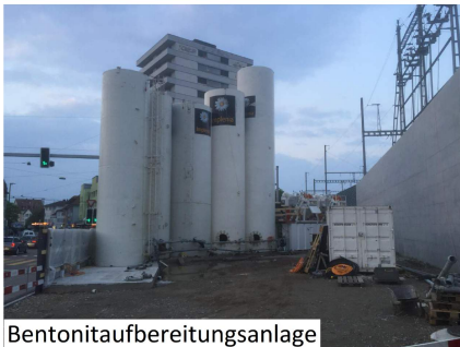
Bentonitaufbereitungsanlage
