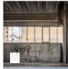
Unterzug Stahlbeton / I- Träger 10.62m
