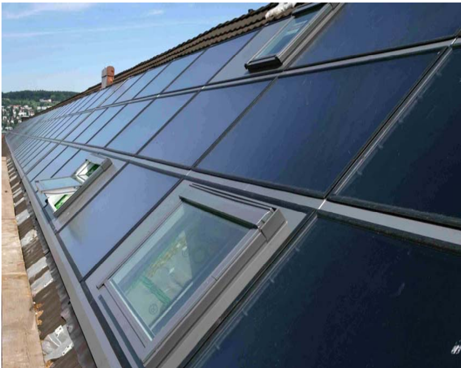
Bild: Flachkollektoranlage in Zürich, keine PVT-Kollektoren!
