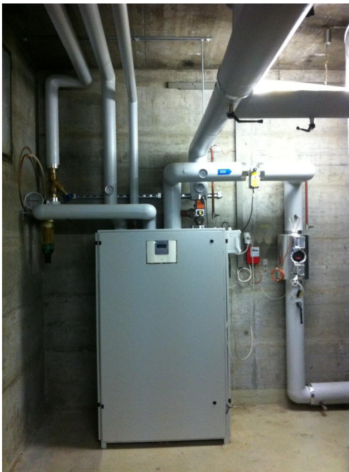
Frischwasserstation und Schema: Sailer GmbH
